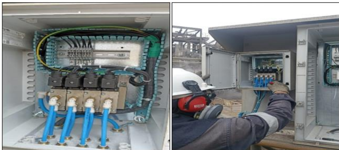
Figura 19. Instalación del tablero de control de válvulas neumáticas.
