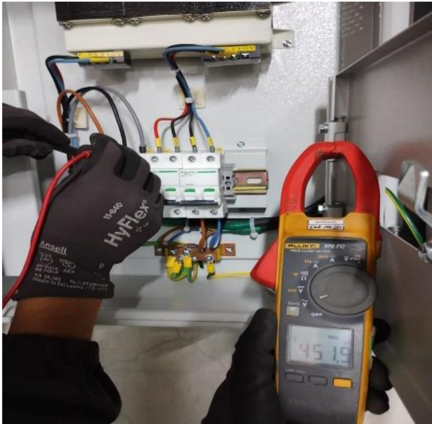
Foto 9. Energización, verificación de tensión.
