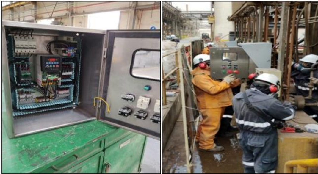
Figura 21. Instalación de tablero de variador de frecuencia
