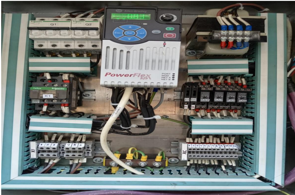
Foto 3. Montaje de tablero variador
