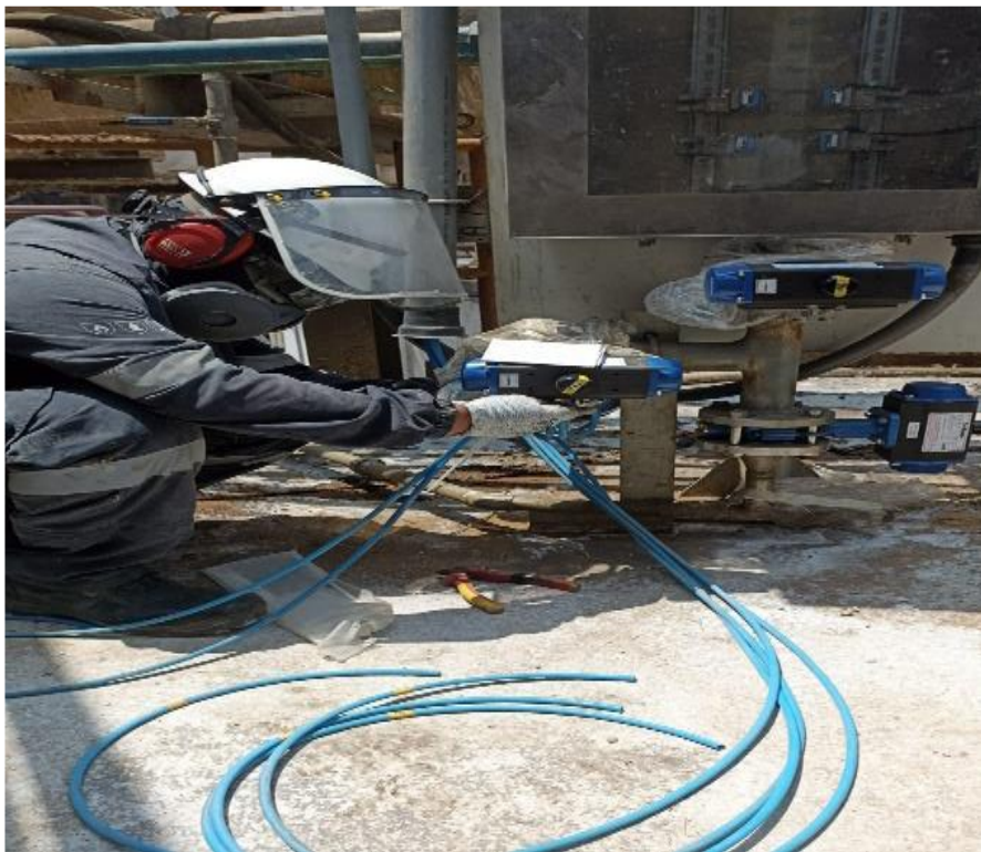
Foto 7. Montaje de actuadores para el tablero de muestreo
