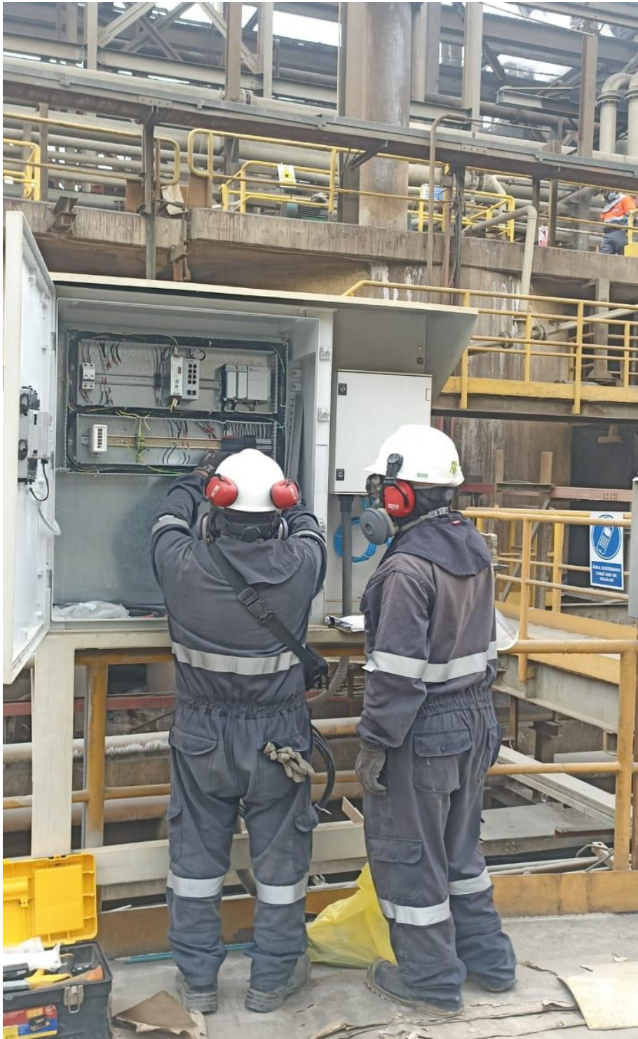
Foto 5. Montaje de equipos en el tablero de control
