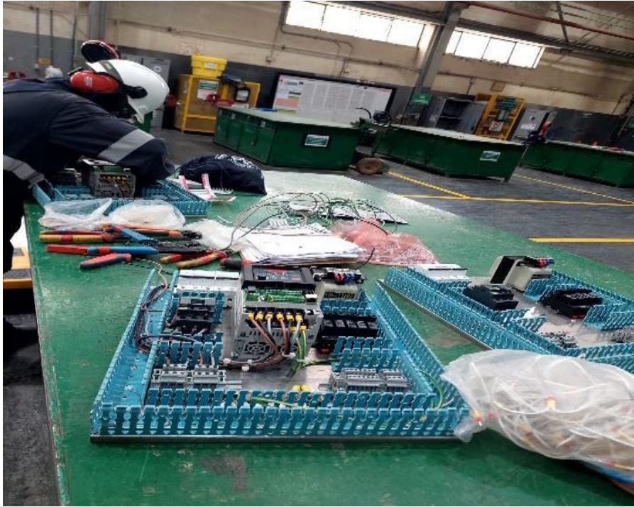
Foto 6. Montaje de equipos en el tablero de variador
