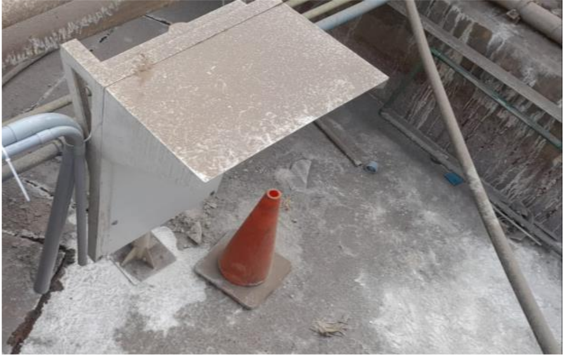
Foto 1. Montaje de soportes con guardas para tablero de muestreo
