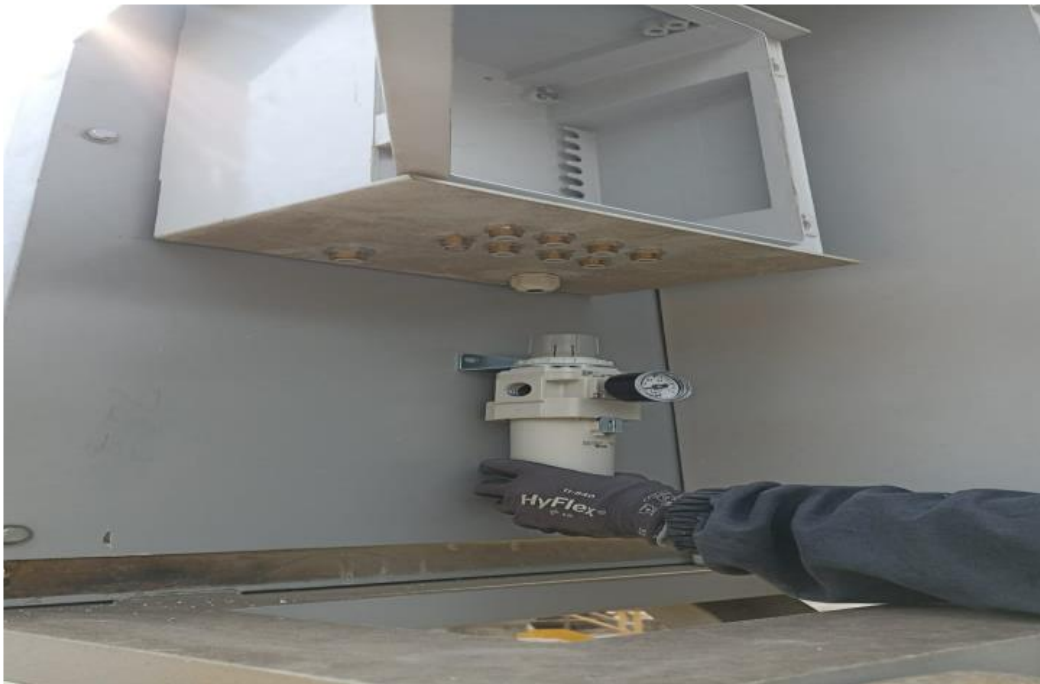
Foto 2. Montaje de tablero neumático
