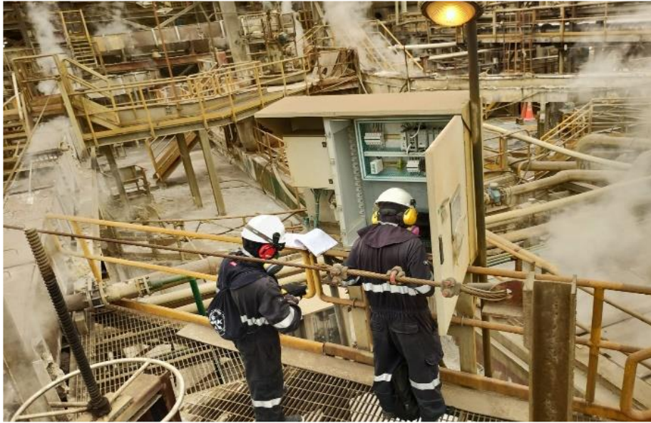
Foto 8. Conexión de tablero de control
