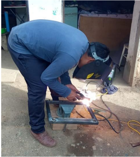
Fotografía 1. Inicio de construcción de la estructura
